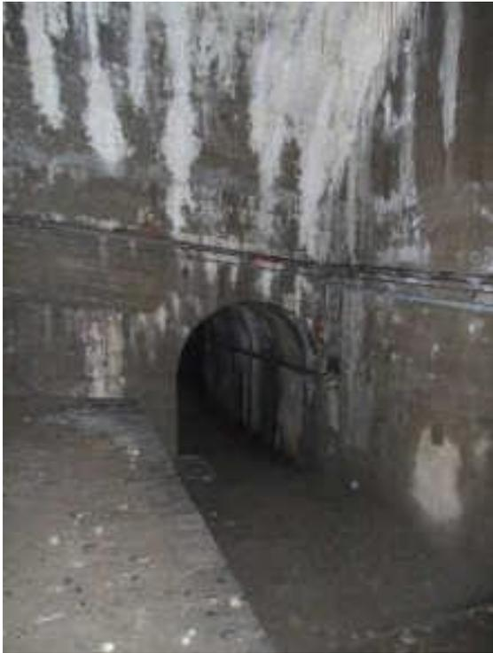
Etwa 50 m vor dem Tunnel endet der Stollen in einer Kaverne. Diese dient zum Auffangen des starken Luftdrucks, welche bei der Durchfahrt von Zügen auftreten.
